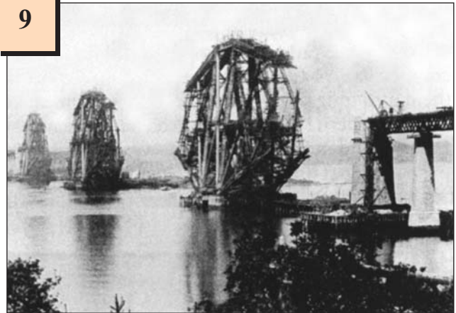
Будівництво опор мосту через Фортську протоку. Шотландія, кінець ХІХ ст.
